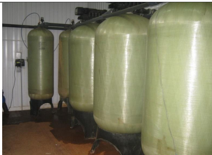
Рисунок 1.6 – Зал станции обезжелезивания центрального водозабора
