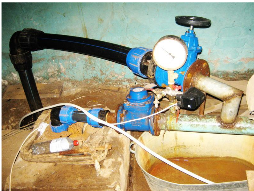
Рисунок 1.2 – Скважина №4948 центрального водозабора
