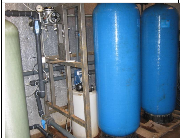
Рисунок 1.9 – Зал станции обезжелезивания водозабора по ул. О.Кошевого
